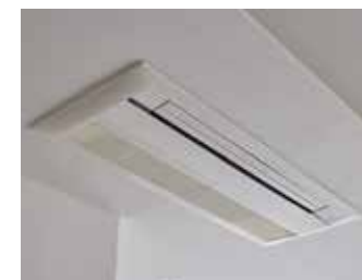
リビング・ダイニング、洋室1 天井埋込カセット型エアコン 実装 ※P-140A、P-140B、P-145A、P-145B タイプは洋室2、3にも実装しております。
